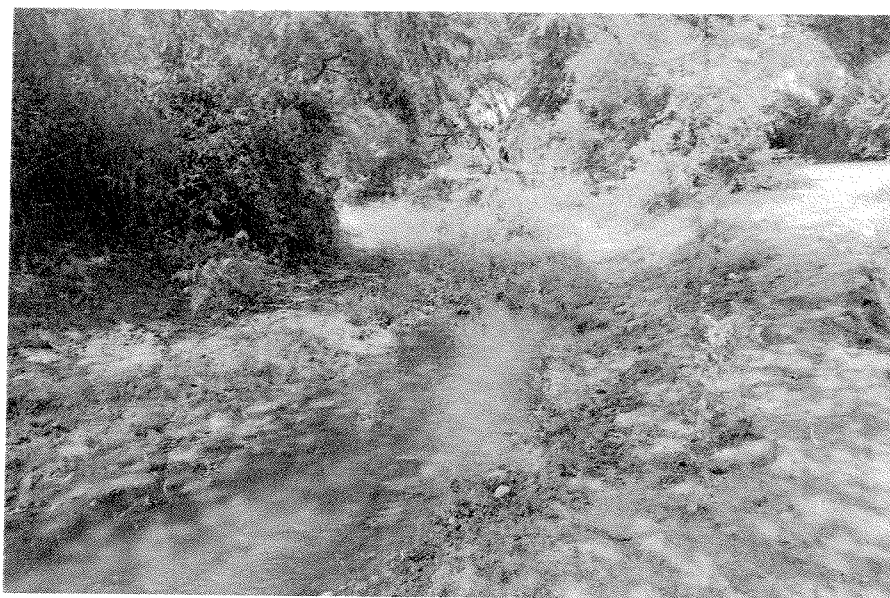
N°02. Tramo del dren colmatado
